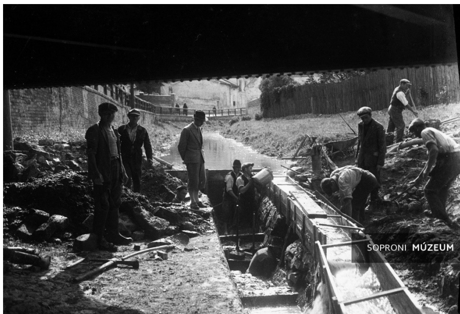
9. ábra. Elgátolás jászolgáttal, vízátervezetés ácsolt fa csatornával és a műtárgy építése a XX. század első felében.
